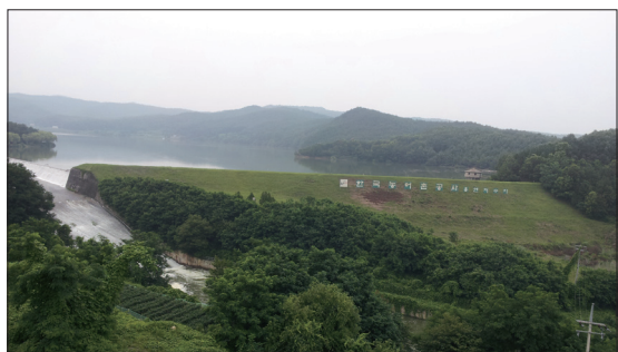
〈그림 9〉 신광분지와 흥해분지사이 계곡에 설치된 용연저수지 (물이 여수로를 윤희하는 모습)
